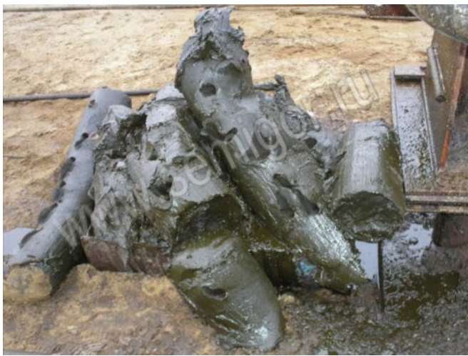
Выемка АСПО продолжается. Очистной поршень все еще находится в камере приема.
