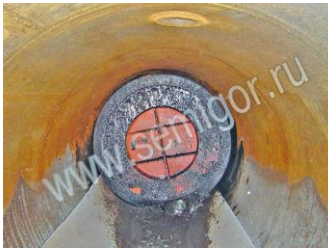
Поршень полиуретановый (манжетный) Семигор-М4-С-1420 (вид спереди) пришел в камеру приема очистных поршней (ПК 10 ООО "Газпром трансгаз Югорск"). Перед поршнем "вынос" из очищенного участка газопровода
